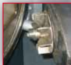
Fragment mieszalnika wewnętrznej atmosfery pieca PKRC
